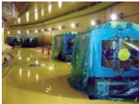
3GeVシンクロトロン内の工事風景
